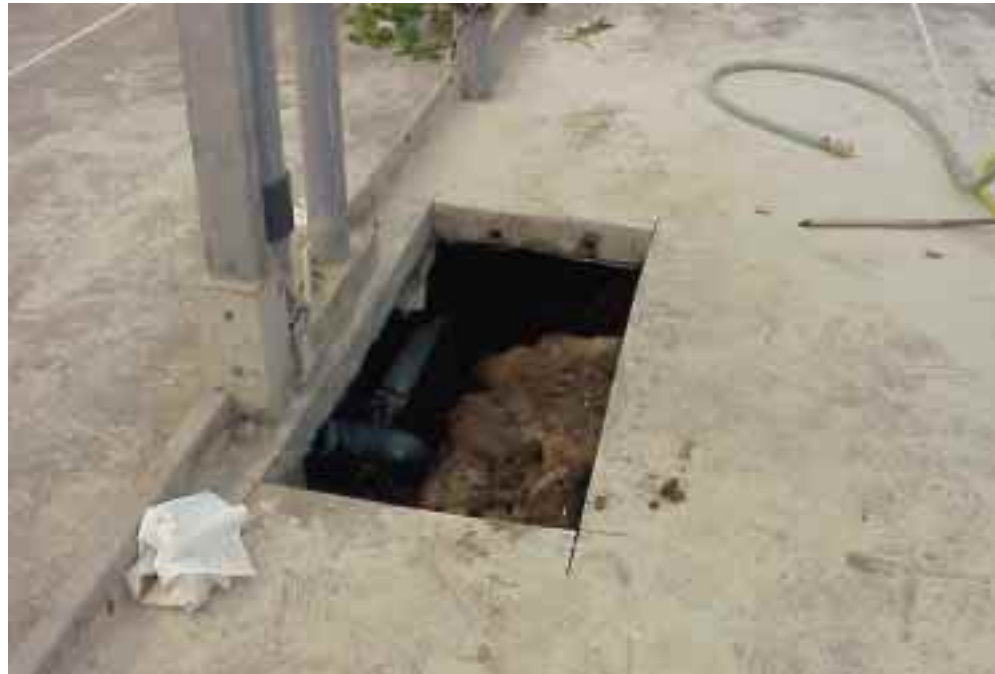
Bij betonvloeren kunnen zich allerlei taferelen afspelen, zoals hier bij een kwekerij waar een halve meter grond wegspoelde. 'Opschuimen' was het enige redmiddel.
