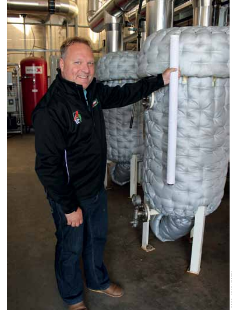
Leon Ammerlaan met een zogeheten kaars bij een kaarsenfilter. Frequent moeten per filter nieuwe kaarsen worden geplaatst, een kostbare aangelegenheid. Een nieuwe kostenpost wordt aanpak van corrosie/scaling.
